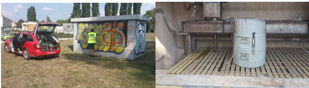
Obr. 12 Monitoring odpadní vody na kmenové stoce při retenční nádrže Jeneweinova
