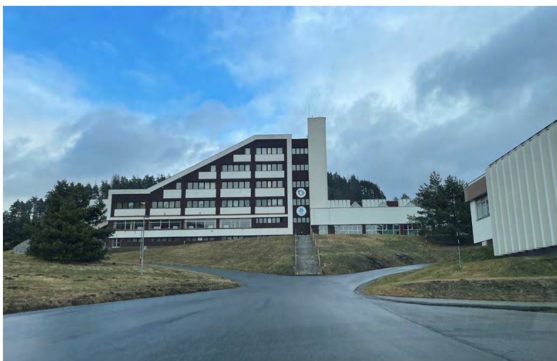
Obr. 2 Úpravna vody Švařec
