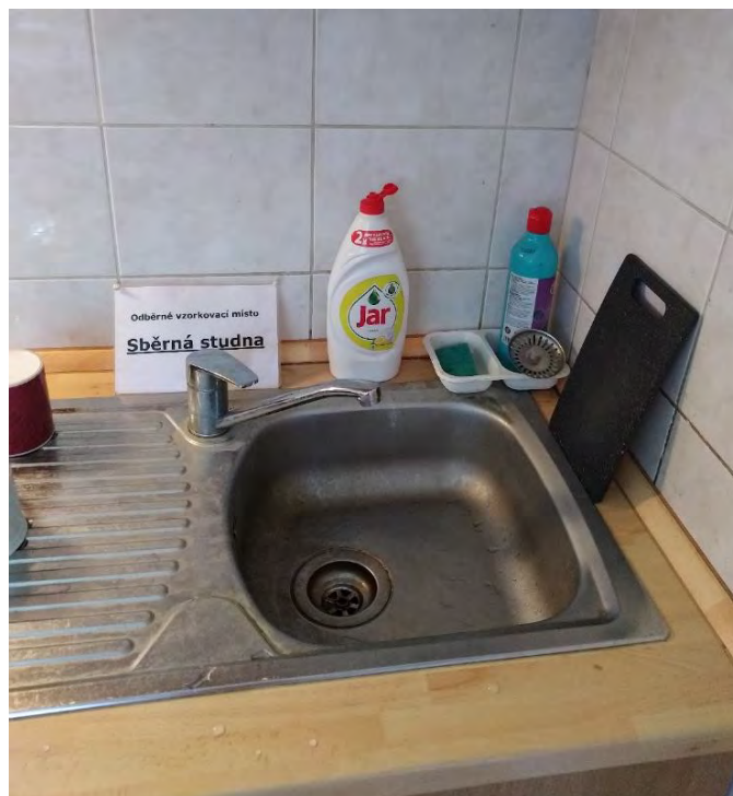
Obr. 5 Odběrné místo pro zdroj Březová nad Svitavou I. zdroj ve správní budově
