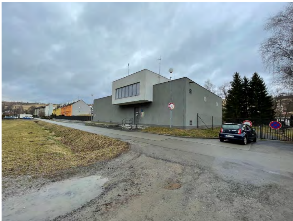
Obr. 6 Vodojem zdroje Březová nad Svitavou II. zdroj
