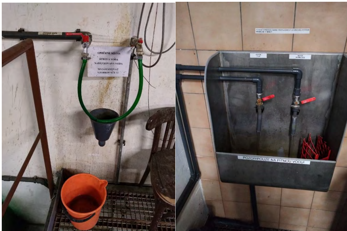
Obr. 3 Odběrné místo pro surovou vodu z VN Vír (vlevo) a odběrné místo pro upravenou vodu z ÚV Švařec (vpravo)
