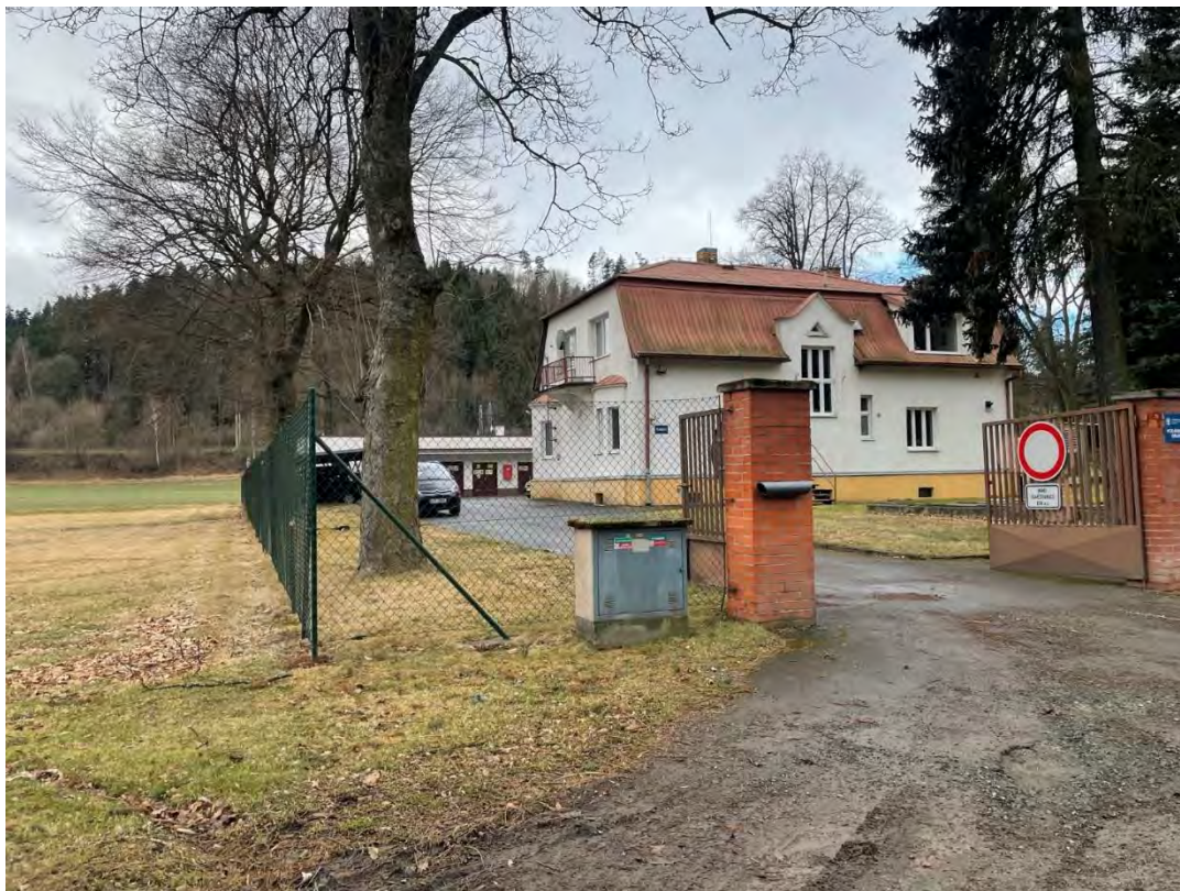
Obr. 4 Správní budova pro zdroj Březová nad Svitavou, odběrné místo pro zdroj Březová nad Svitavou I. zdroj
